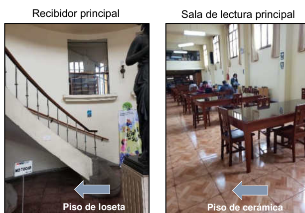
Pisos de la Biblioteca Pública de Tacna
