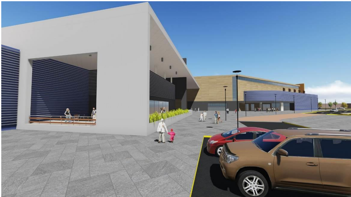
VISTA PEATONAL DE RESTAURANT PUB Y HACIA EL FONDO INGRESO DE HIPERMERCADO
