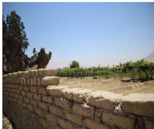
Imagen 23: Muro Perimétrico de adobe
