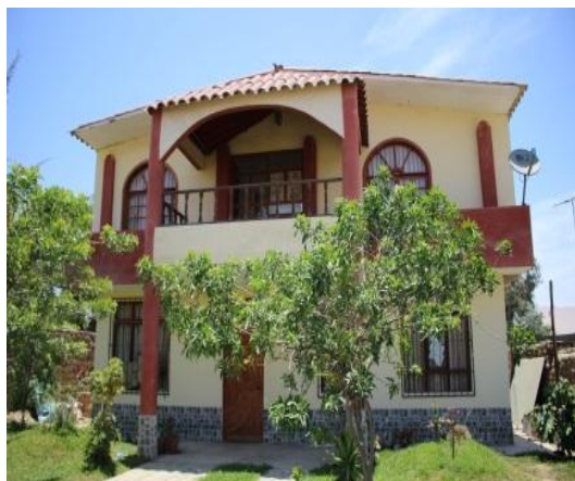
Imagen 22: Vivienda de Ladrillo
