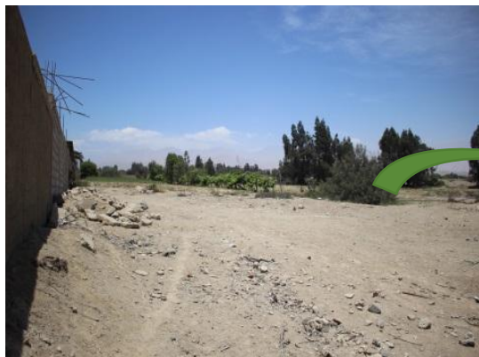
Imagen 31: Desmonte de material de obra
