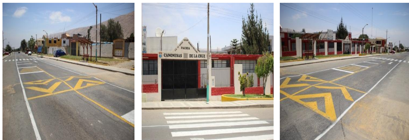
Imagen 24: Pistas estado 7/10 según el equipo de estudio, con una señalización vial correctamente ubicada y elaborada
