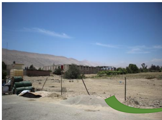
Imagen 32: Colocación de material para obra
